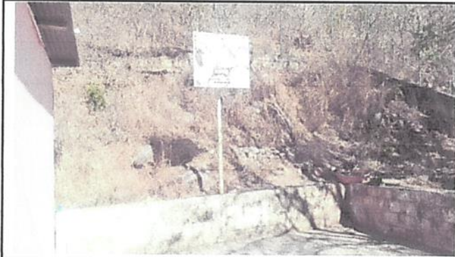
Foto1: Aca podemos ver el peligro que presenta el muro que ya no soporta la tierra que tiene sobre la malla por lo que se necesita aplicar cemento rociado en donde s eve el zacate.
