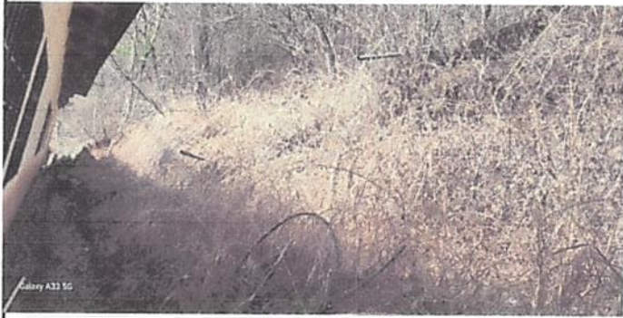
Foto1: Aca podemos ver el peligro que presenta el muro que ya no soporta la tierra que tiene sobre la malla por lo que se necesita aplicar cemento rociado en donde s eve el zacate.
