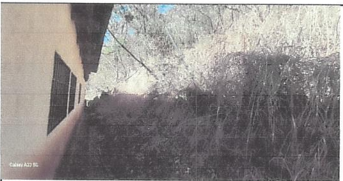
Foto 5 : Es latente el peligro donde se ve que se desplomo el muro perimetral donde necesita ser cambiado por muro de contencion .
